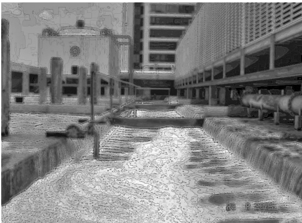
รูปแสดง การประกอบทอผึ่งน้ำแบบ Cross flow จำนวน 3 ชุด เรียบร้อยและใช้งาน
